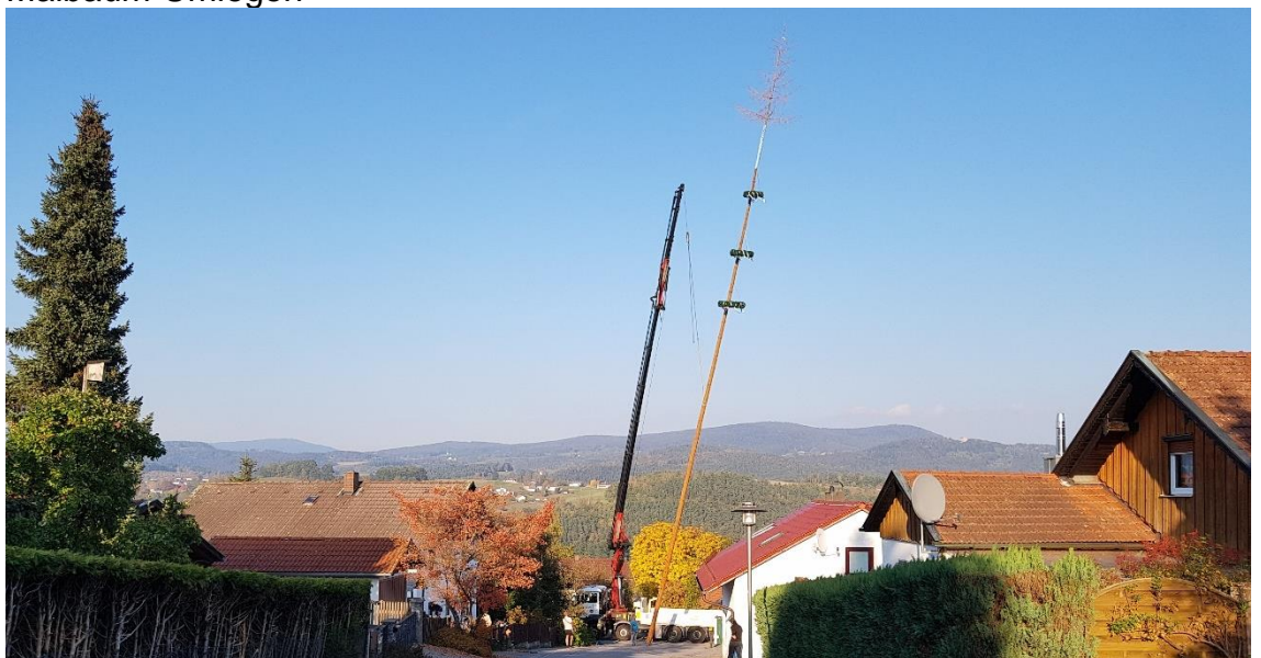
Michael Holzfurtner mit Kran
