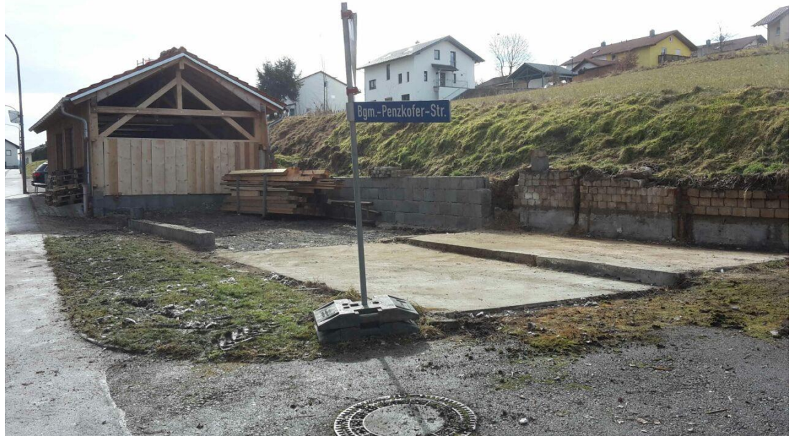
Vollständig entfernter Bauteil 2
